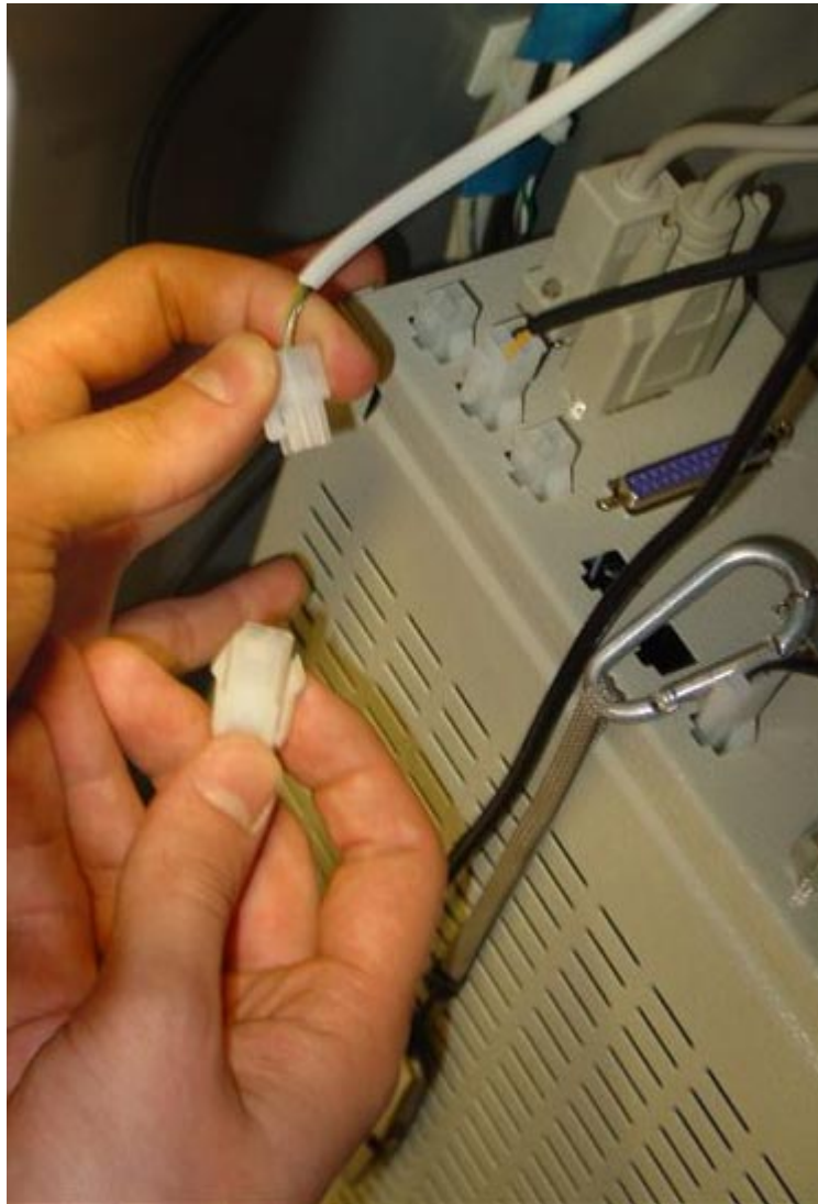
Рис. 30. Шнур питания модема соединить с кабелем таймера
